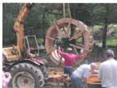
Installation de la roue
